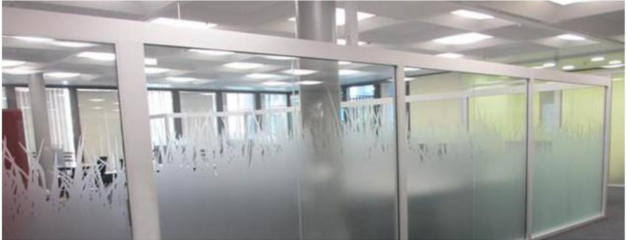
Polymere Vinylfolie mit Kristalloptik und Permanentkleber. Dieses Material wurde speziell für Digitaldruck auf grossformatigen Inkjetdruckern entwickelt und eignet sich zum Drucken mit Eco-Solvent, Solvent und UV-härtenden Tinten.
