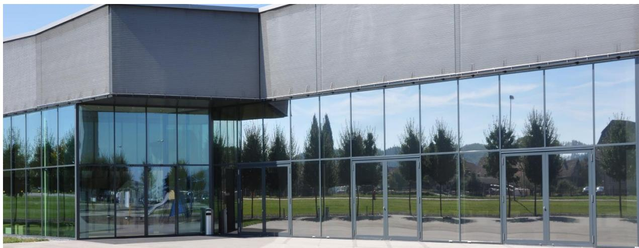
Die 6000 mirror Exterior ist ein Sichtschutz und gleichzeitig eine Folie zur verstärkten Wärmestrahlungsreduktion. Spiegeleffekt mit Einwegdurchsicht (abhängig von den Lichtverhältnissen). Energieeinsparung durch Entlastung von Klimaanlage.
